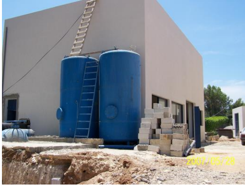
ترميم مبنى محطة الضخ
