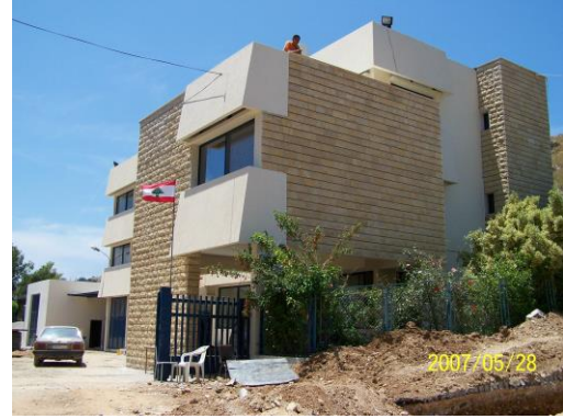
ترميم مبنى الإدارة
