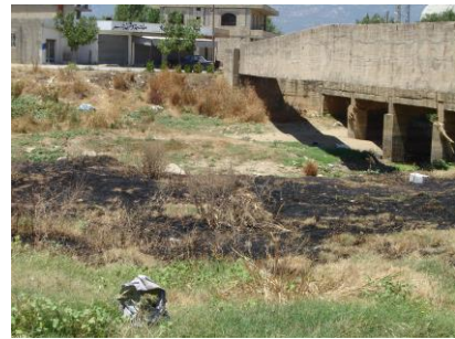
موقع جسر المنصورة قبل التعزيل
