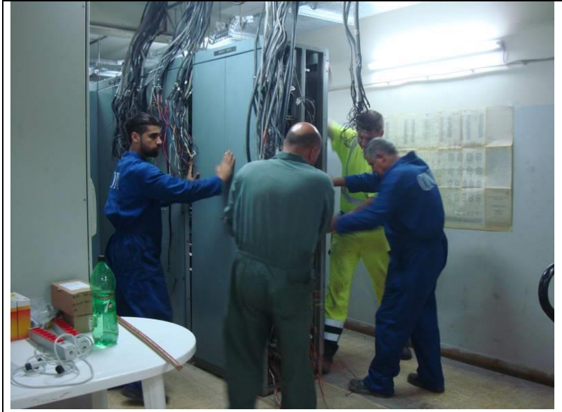
فك الخزائن الكهربائية القديمة العائدة لتشغيل المجموعات الإنتاجية رقم ١ ورقم ٢ في المعمل.
