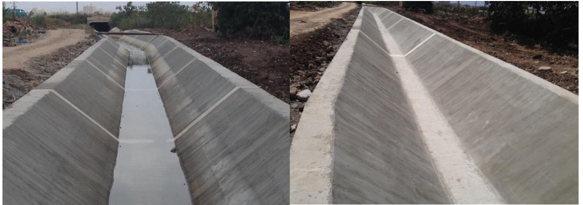
تمرير المياه في القناة (بعد التجديد) القناة بعد إنجاز الأشغال والتنظيف ومعالجة العيوب
