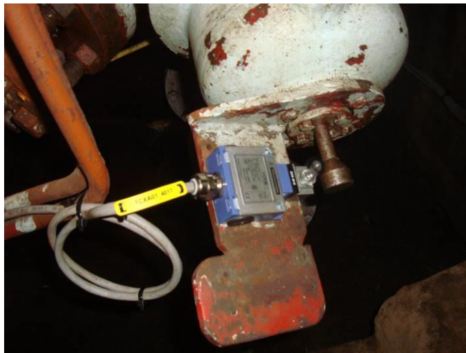
تركيب أجهزة قياس واستشعار (Sensors, detectors, flow meter, ...) جديدة على الأجهزة والمحركات الميكانيكية العائدة للمجموعات الإنتاجية في معمل جون.
