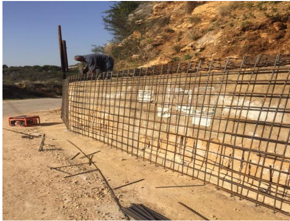
أعمال حديد التسليح لحائط الدعم
