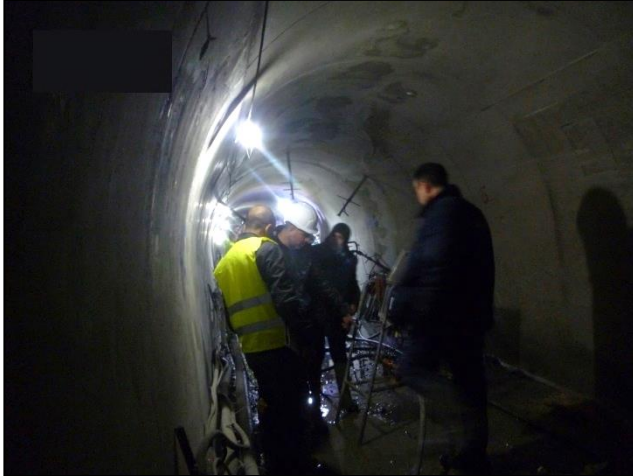
عملية تفحص الـ Consolidation Grouting
