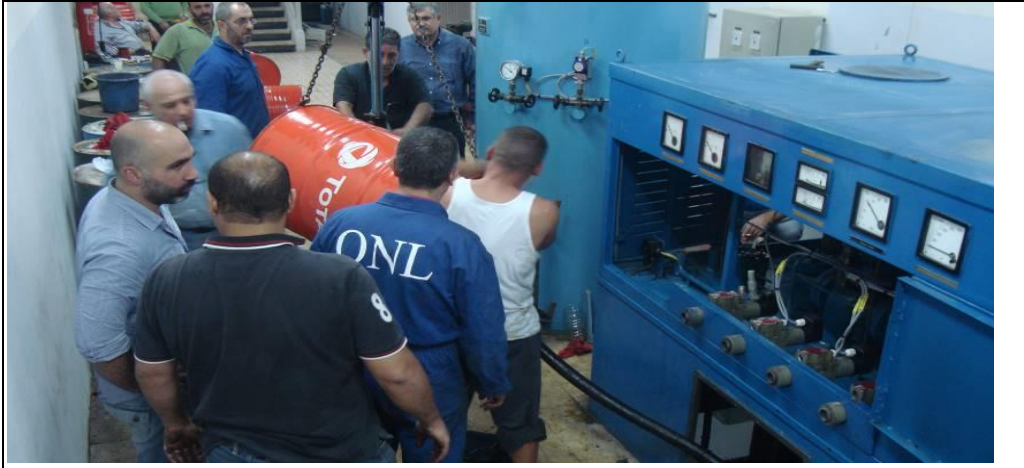
تنظيف أفلاتر واستبدال زيوت المنظم "Régleur" للمجموعات الإنتاجية في المعمل.
