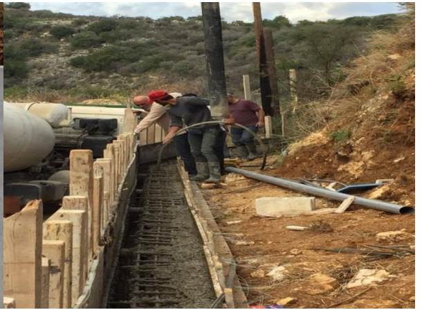
أعمال صب الخرسانة ورجها لحائط الدعم
