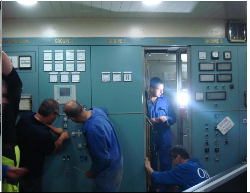
تركيب أجهزة قياس وتحكم جديدة على لوحة التحكم داخل غرفة التحكم "Control Room" العائدة لمعمل جون
