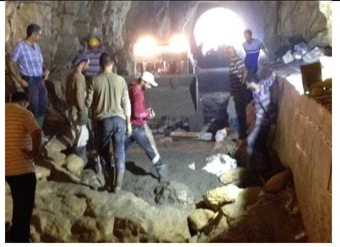
أعمال تأهيل النفق وصب الخرسانة مع الدبش داخل النفق
