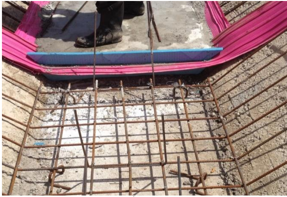
تركيب الـ (waterstop) عند الفواصل الإنشائية العرضية والطولية وتركيب ألفلين عند فواصل التمدد للقناة
