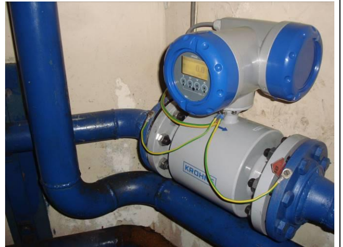
تركيب أجهزة قياس واستشعار (Sensors, detectors, flow meter, ...) جديدة على الأجهزة والمحركات الميكانيكية العائدة للمجموعات الإنتاجية في معمل جون.
