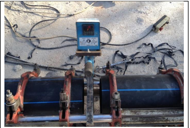
عملية تلحيم القساطل
