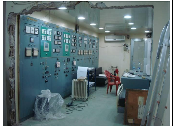
توسيع وتأهيل غرفة التحكم "Control Room" في معمل جون وتجهيزها بالمعدات والأجهزة الحديثة والمتطورة لزوم النظام الجديد للتحكم وللمراقبة الـ "Automation system" العائد للمعمل
