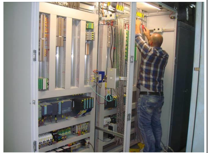
تركيب الخزائن الكهربائية الجديدة العائدة لنظام الـ "Automation" الجديد
