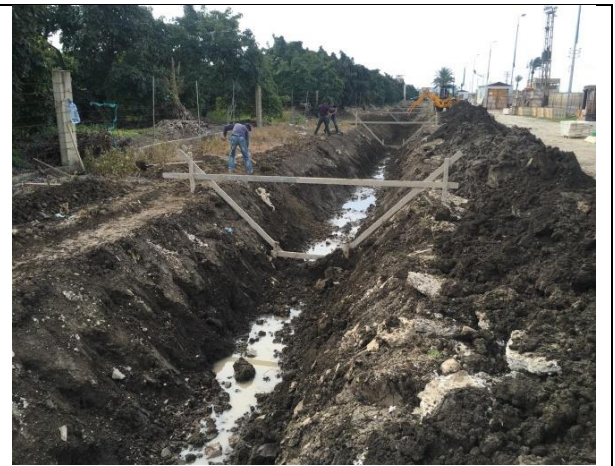
حفر وتسوية الأرض عند حافة القناة (٤٠سم) الوضع بعد إنجاز الأعمال لحافة القناة
