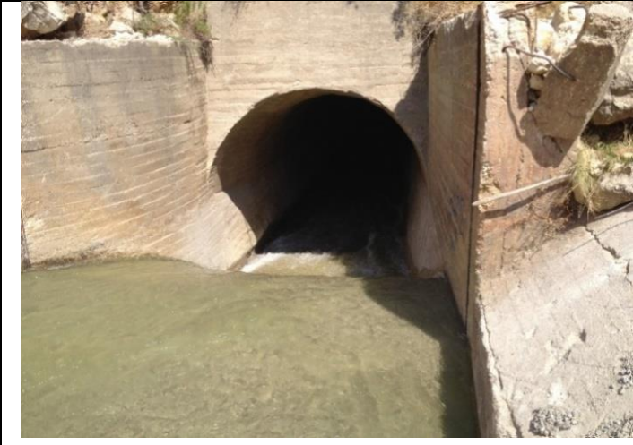
جريان المياه داخل النفق بعد إنتهاء الأشغال
