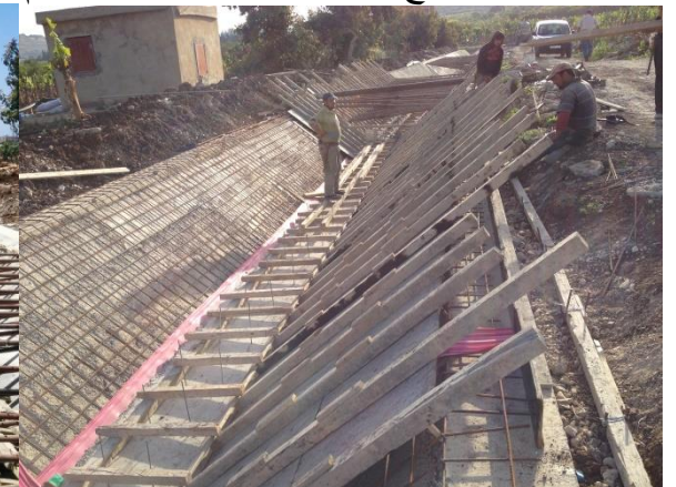
تركيب القالب الخشبي لجدران القناة
