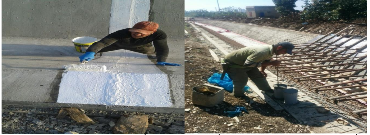
أخذ عينات من خرسانة جدران القناة تأهيل ومعالجة جميع أفواصل بمادة البولوريثان (طبقتين)
