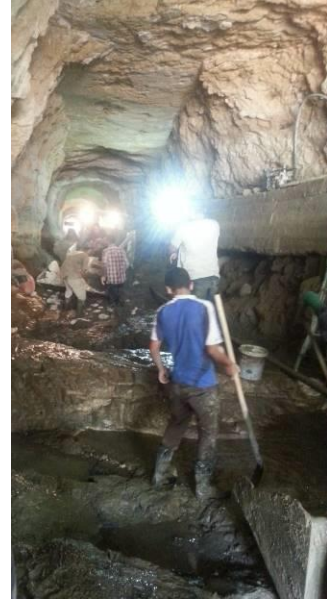
ازالة المياه من الحفر وتنظيف ارضية النفق من الأتربة والأوساخ لتحضيرها لوضع الخرسانة عليها
