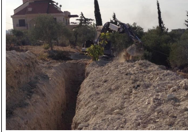
أعمال حفر الخندق
