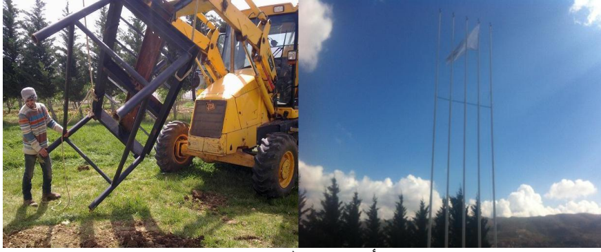
تركيب أعمدة مقابل مبنى الإدارة
