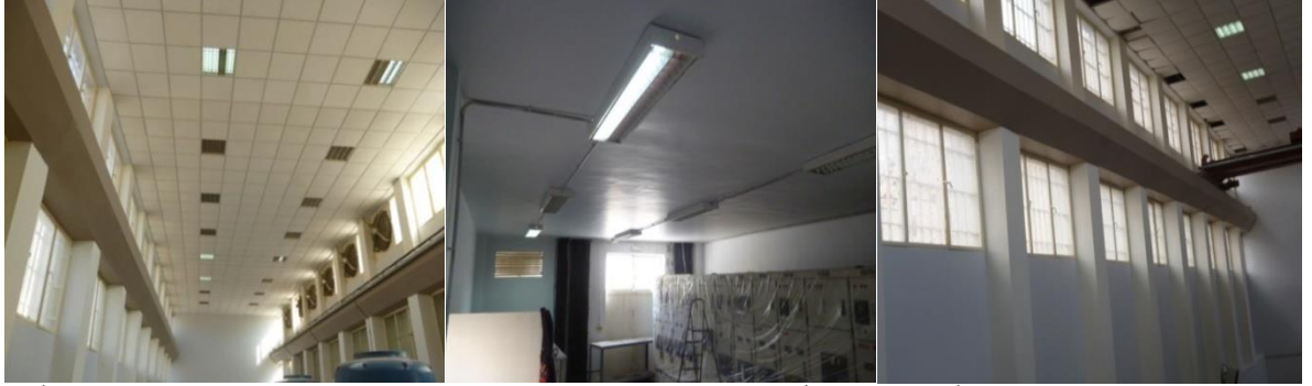
المحطة من الداخل بعد التأهيل وتنفيذ أعمال الدهان والطرش الداخلي السقف المستعار بعد التأهيل والصيانة
