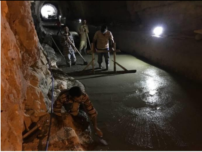
أعمال تأهيل النفق وصب الخرسانة مع الدبش داخل النفق
