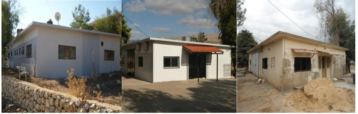
مبنى مكاتب قياسات المياه - سد القرعون بعد الترميم والتأهيل
