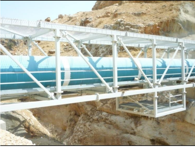
جسر عبور الليطاني بعد تركيب الشبك الحديدي
