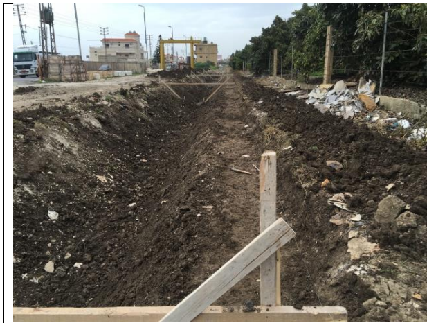
حفر وتسوية الأرض عند حافة القناة (٤٠سم) الوضع بعد إنجاز الأعمال لحافة القناة
