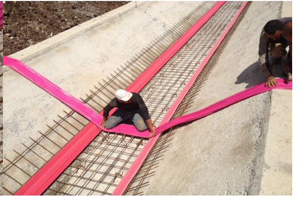
تركيب الـ (waterstop) عند الفواصل الإنشائية العرضية والطولية وتركيب ألفلين عند فواصل التمدد للقناة
