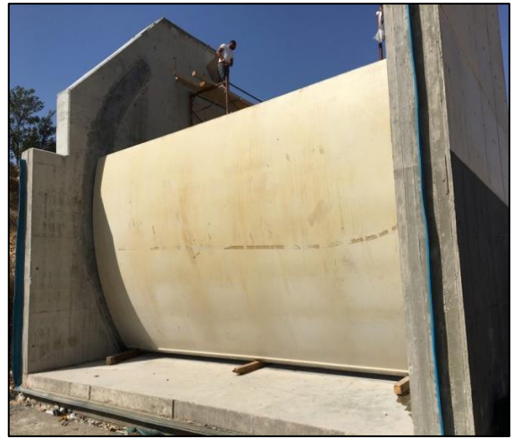
تركيب بوابة Radial gate للتحكم بتدفق المياه في قناة قليا
