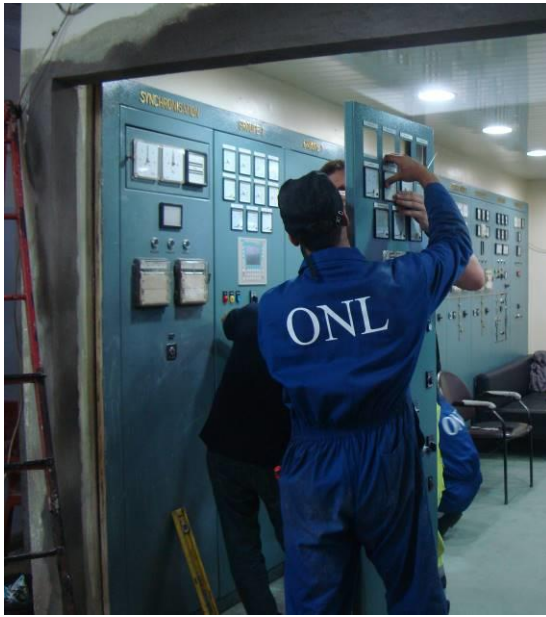
تركيب أجهزة قياس وتحكم جديدة على لوحة التحكم داخل غرفة التحكم "Control Room" العائدة لمعمل جون
