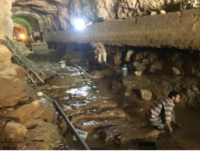
ازالة المياه من الحفر وتنظيف ارضية النفق من الأتربة والأوساخ لتحضيرها لوضع الخرسانة عليها
