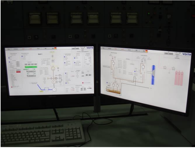
النظام والبرنامج الجديد "SCADA" وغرفة التحكم والمراقبة "Control room" في معمل جون.
