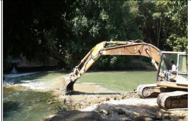
ازالة المياه من الحفر وتنظيف ارضية النفق من الأتربة والأوساخ لتحضيرها لوضع الخرسانة عليها
