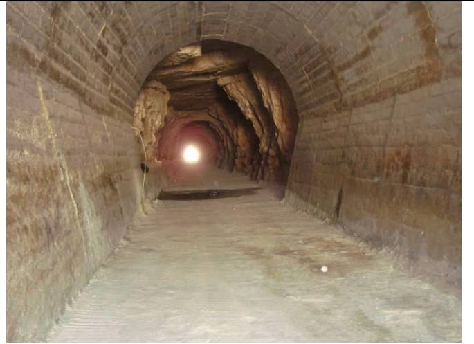
وضع النفق بعد تنفيذ الأشغال داخل النفق بعد التأهيل
