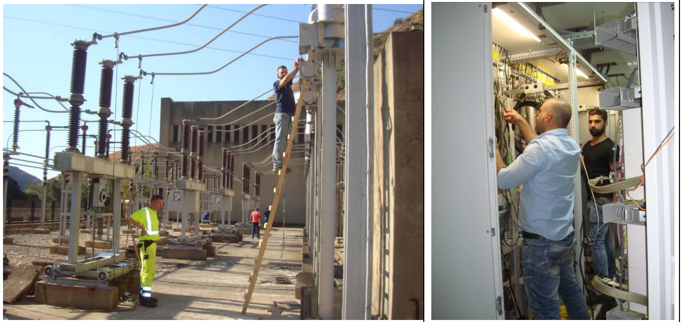
أشغالتجهيز ومد كابلات وربطها بين الأجهزة الكتروميكانية والقطع الكهربائية في المعمل والخزائن الجديدة العائدة لنظام الـ"Automation" الجديد
