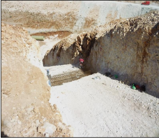
مجرى تصريف مياه المفيض
