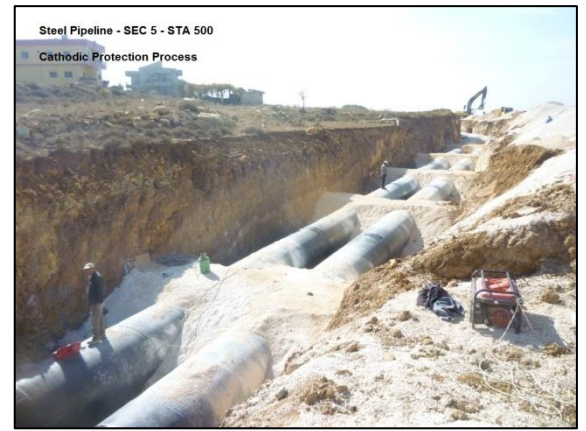
أعمال الـ Cathodic Protection في منطقة مرجعيون
