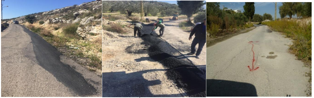
العيوب الناتجة خلال فترة الضمان تزفيت ومعالجة الأماكن المتضررة الوضع النهائي بعد المعالجة
