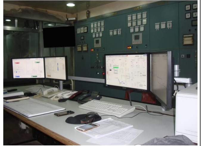
النظام والبرنامج الجديد "SCADA" وغرفة التحكم والمراقبة "Control room" في معمل جون.
