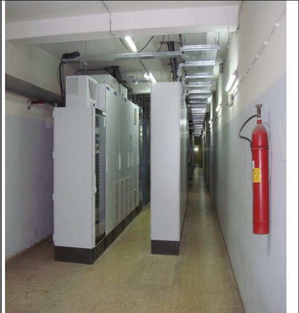
الخرائن الكهربائية الجديدة العائدة لنظام الـ "Automation system" الجديد في معمل جون
