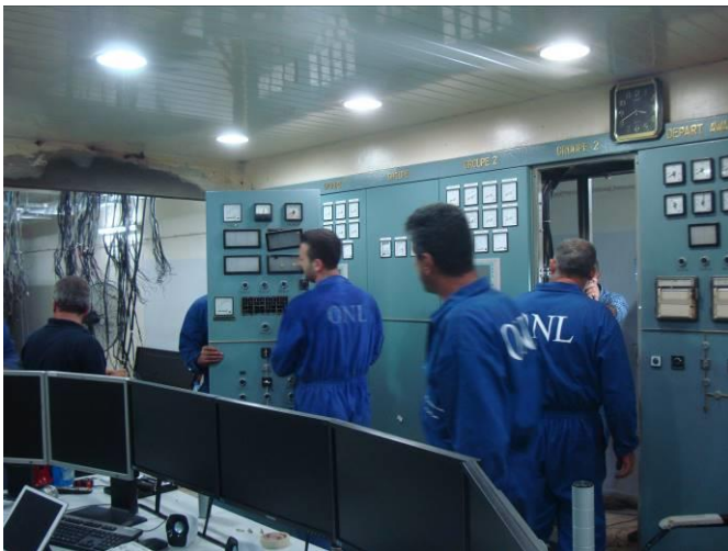
توسيع وتأهيل غرفة التحكم "Control Room" في معمل جون وتجهيزها بالمعدات والأجهزة الحديثة والمتطورة لزوم النظام الجديد للتحكم وللمراقبة الـ "Automation system" العائد للمعمل
